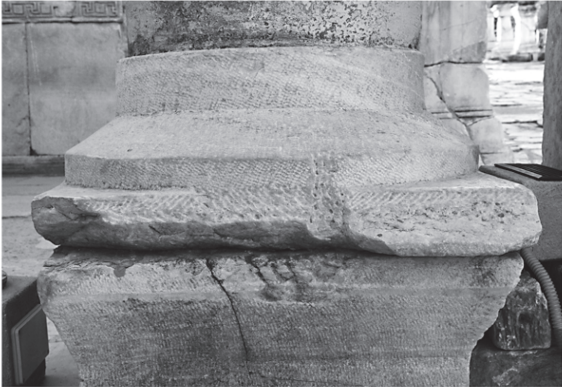
1 Säulenbasis 016B , Ansicht West
